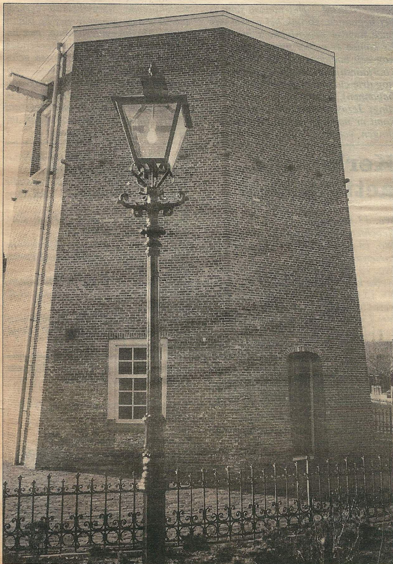
Bij de molen is een antieke lantaren geplaatst.
